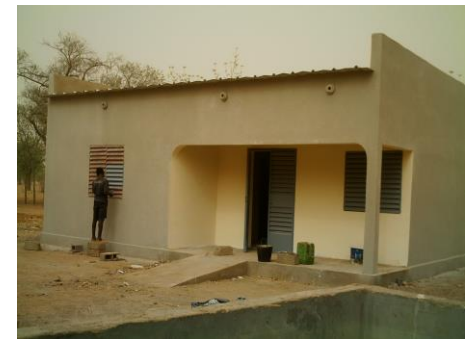
Logement d'instituteur à Kaba
